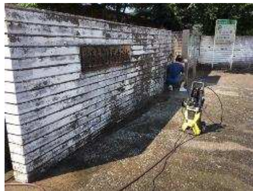
外壁高圧洗浄
